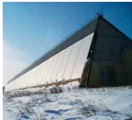
Рис. 1. РЛС «Днепр» на РЛУ ОС-1 (г. Иркутск).
