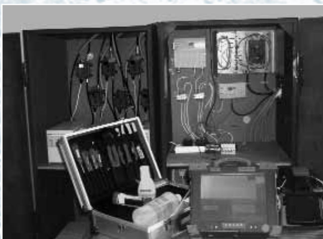
Рис. 3. Комплект сварочного и измерительного оборудования, использовавшегося при монтаже оптической сети в г. Сосновый Бор
