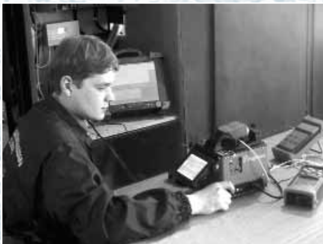
Рис. 2. Инженер-монтажник Гагин В.В. приваривает пигтейл в распределительном шкафу оптического узла кабельной сети г. Сосновый Бор
