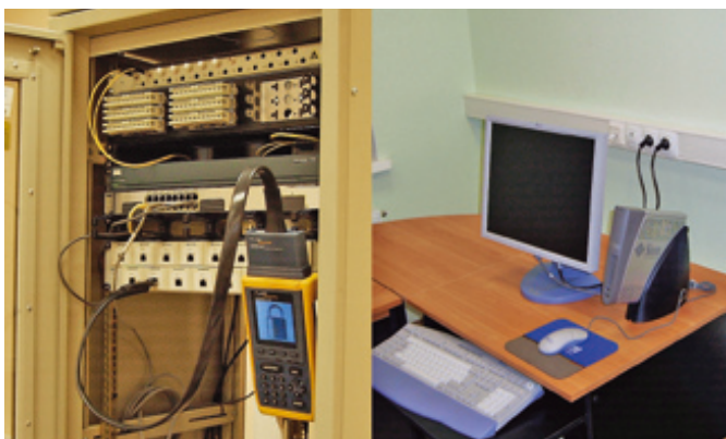
Работа по оснащению Единого Центра Данных на базе НИЦ ГНИНГИ Минобороны России. Тестирование коммутационного оборудования (слева), рабочее место оператора на базе консоли Sun Ray
