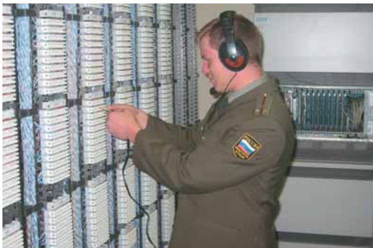
Кросс узла связи
