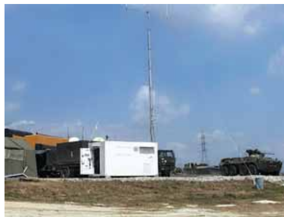
Рис. 3. Базовые станции контейнерного типа
