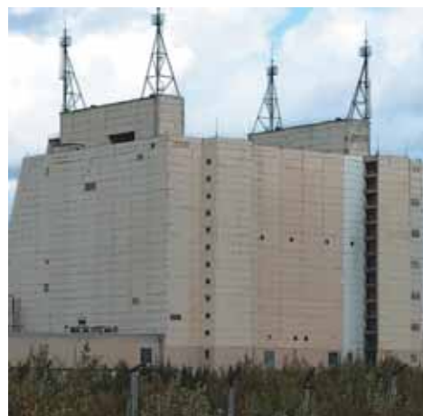
Передающий центр РЛС
