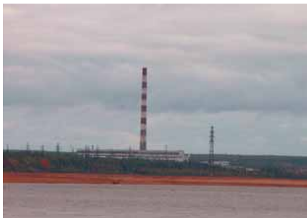
Печорская ГРЭС большую часть вырабатываемой электроэнергии поставляет для РЛС «Дарьял»
