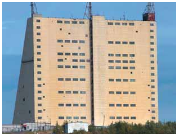
Задача приемного центра – прием, обработка отраженного сигнала и передача информации на вышестоящий КП
